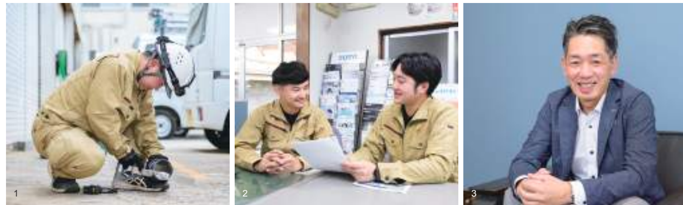
1 道路下に埋設された本管から水道を引き込み、建物内の水道施設に連結させるため、配管するパイプを、現場で使うサイズに合わせ丁寧に切断する 2 現場の作業に向けて社内ミーティング中の工務部社員 3 大館禎典社長。山陰パナソニック株式会社出雲電材営業所所長を経て、2022年山陰冷暖に入社。同年4月、代表取締役役に就任。
