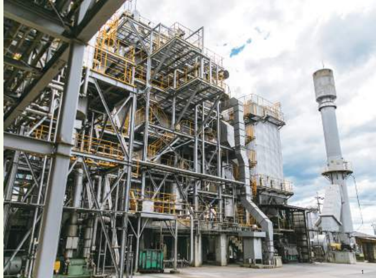
1 境港市の約3分の2世帯の使用電力分にあたる年間4500万kwhを発電する最大出力5700kwの発電設備 2 木質チップを燃焼させて蒸気を生ずる。常用蒸気温度は453度にも上る 3 フィーダーでボイラーに木質チップを供給。年間8万トンが燃料として使われる 4 「エネルギーの地産地消で地域に貢献したい」と話す来海邦夫社長
